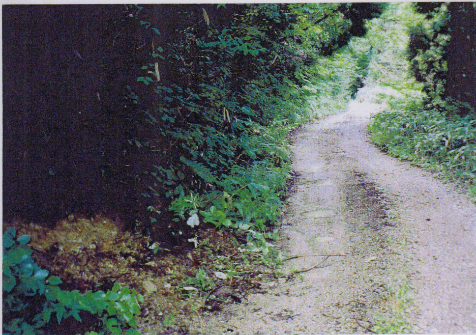
図-4-23 ⑧の地すべりの道路面上の水溜まり
