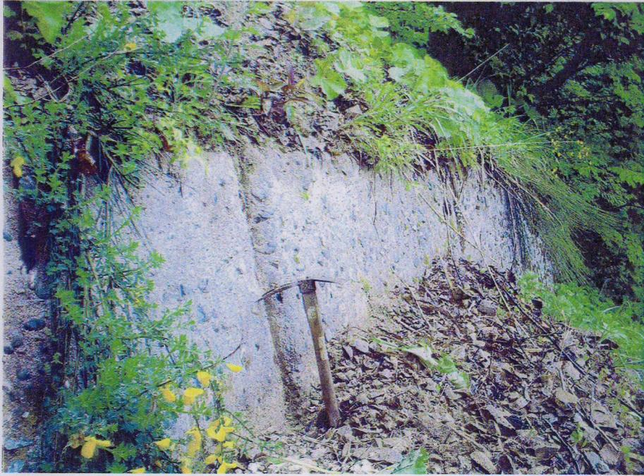
図-4-10 ⑤の地すべり内の道路擁壁に見られる亀裂
