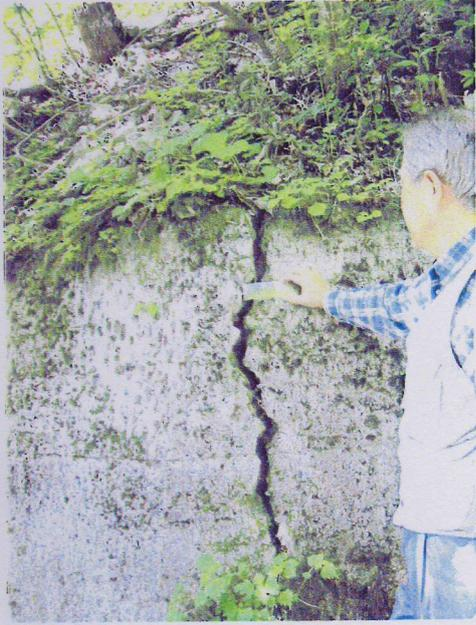
図-4-7 ③-Bの地すべり内の道路擁壁に見られる開口亀裂
