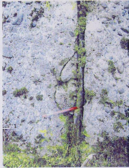
図-4-8 ③-Bの地すべり内の道路擁壁に見られる亀裂
