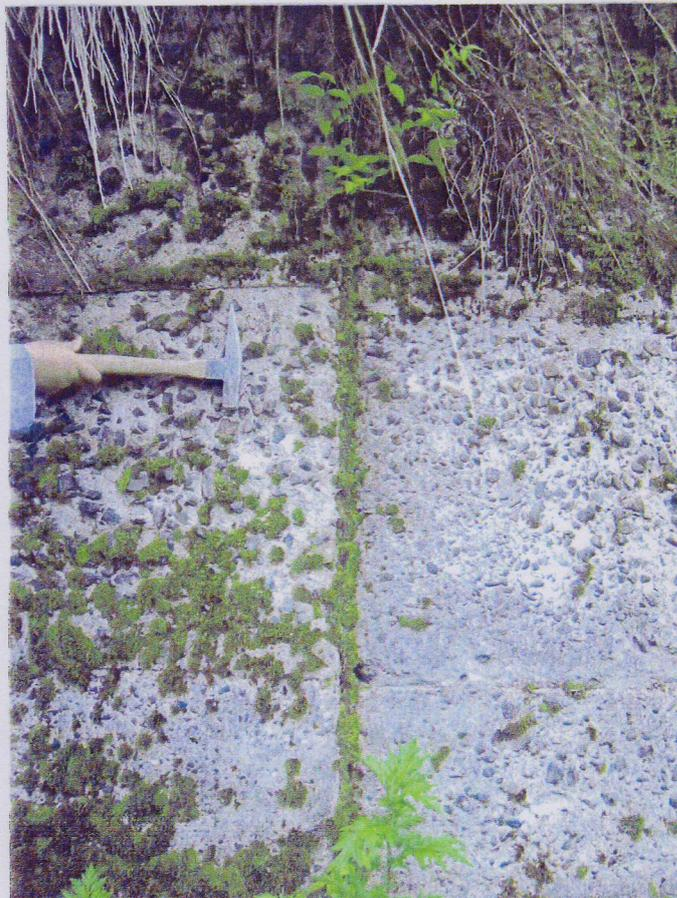
図-4-9 ④の初期的変形地形内の道路擁壁に見られる亀裂
