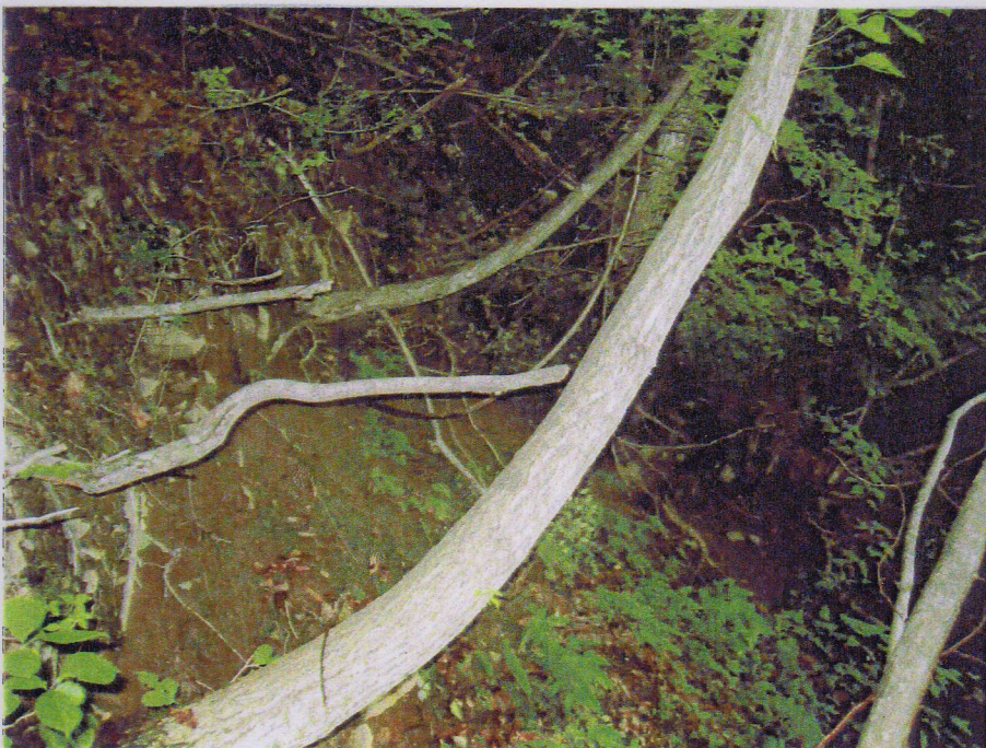
図-4-6 ③-Bの地すべり内部の二次地すべりの滑落崖
