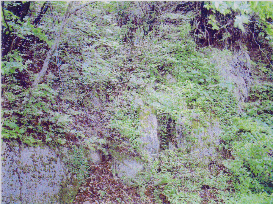
図-4-5 ③-Bの地すべり側壁の凹地形と側壁の変状
