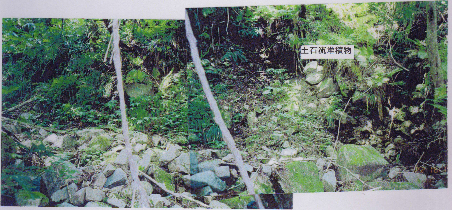
図-2-2 谷を埋める土石流堆積物
